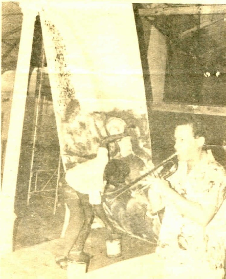
L'heure de la démolition. Le théâtre Vollard se retire en fanfare.
