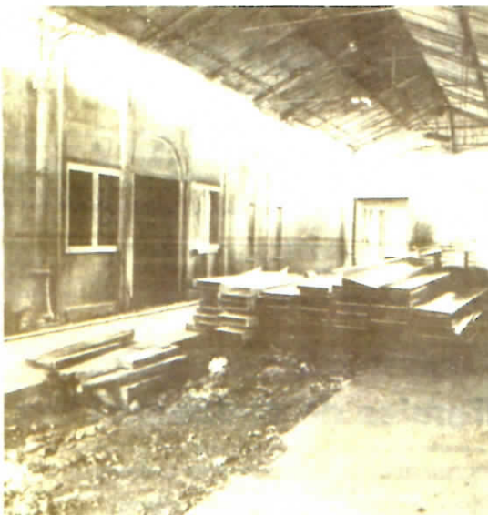
La construction du nouveau théâtre ainsi que les aménagements coûtent 14 millions de francs.
